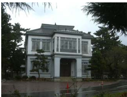
船橋の空挺館
